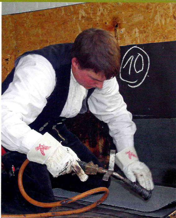
Jakob Richter an der letzten Aufgabe: ab- dichten einer Innenecke mit Bitumen.
